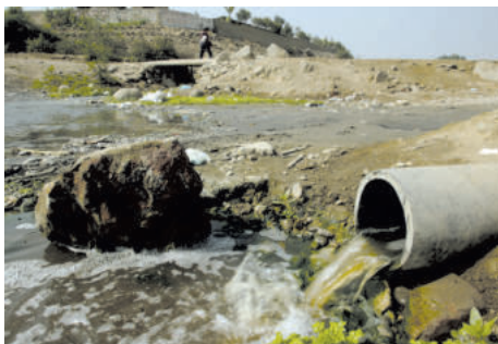
Vertimiento de desagüe doméstico e industrial en un río de la costa.
