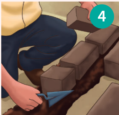
Disponer la segunda capa de adobes, rellenar con barro y emparejar.
