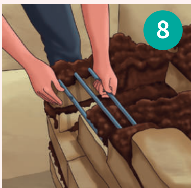
Colocar las varillas de 5/8 de pulgada de diámetro por 40 cm de largo.
