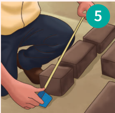
Las medidas de la cámara de combustión deben ser de 20 cm de ancho \times 40 cm de profundidad \times 20 cm de alto.
